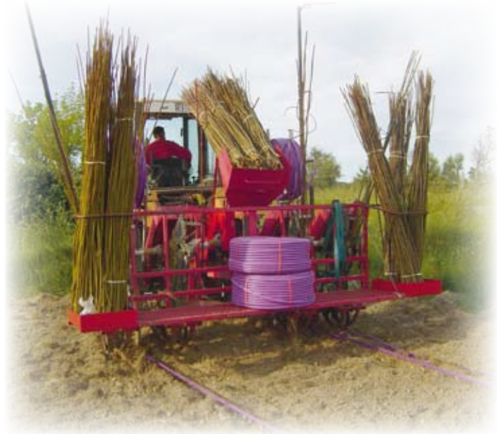
plantation de saules et mise en place d'unibioline. Photo: Bionis
